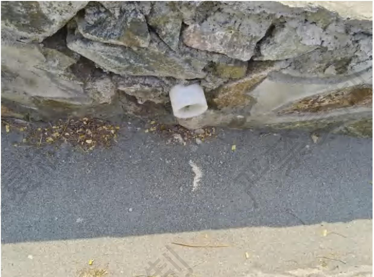
图 2.4-7.2 坝面排渗导水管
