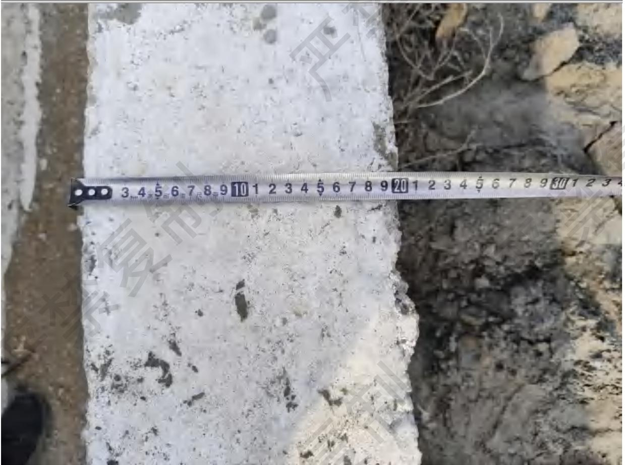
图 2.4-12 排洪明渠壁厚
