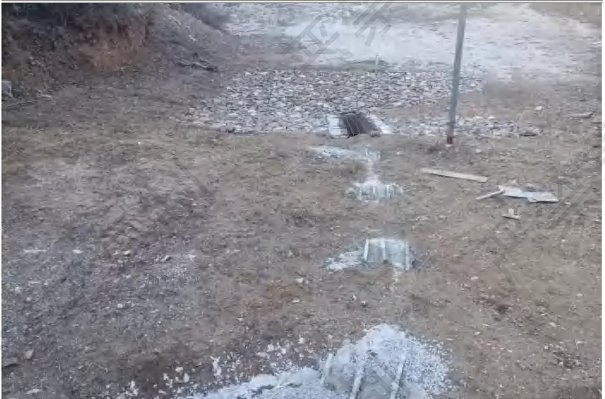
图 2.4-6 排水拱涵进水口及防护
