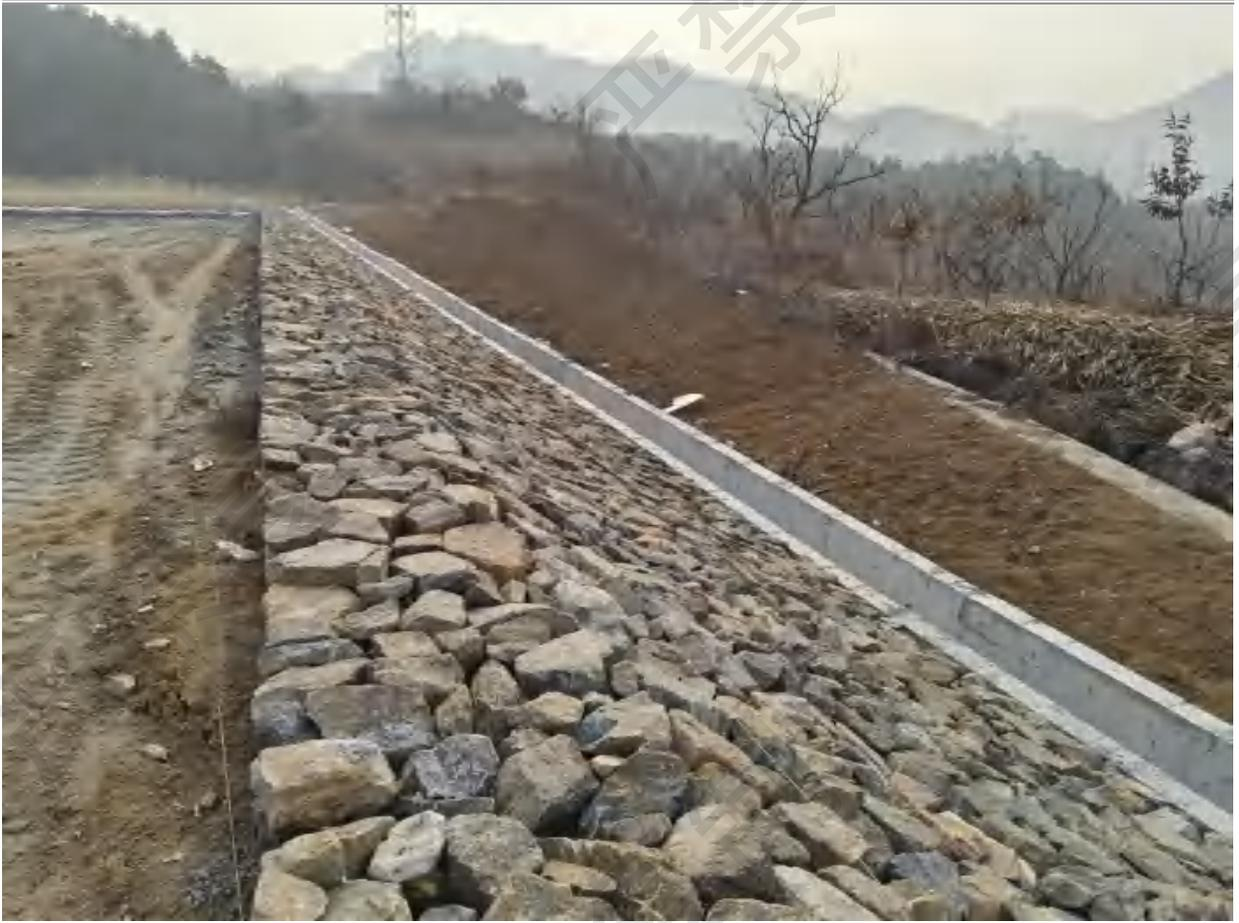
图 2.4-10 临尾砂侧干砌块石护坡
