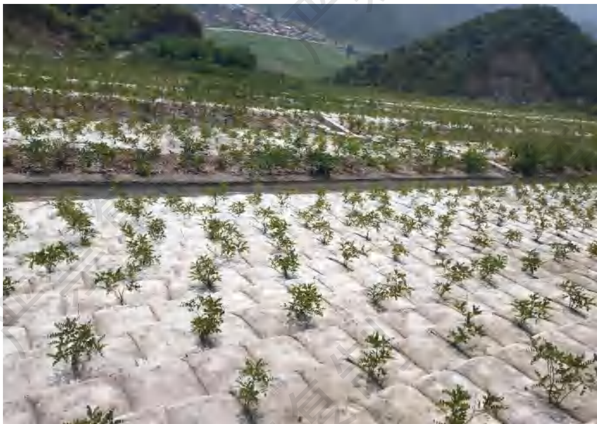
图 2.4-3 堆积坝外坡面
