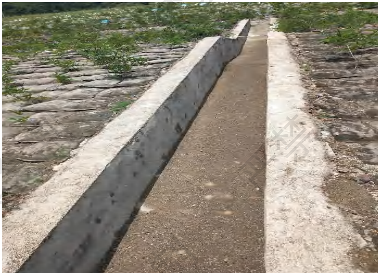
图 2.4-6 坝面竖向排水沟
