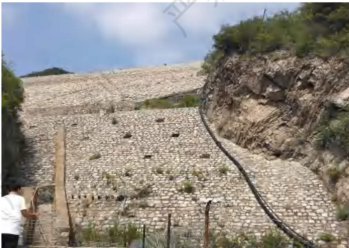
图 2.4-2 初期坝外坡面
